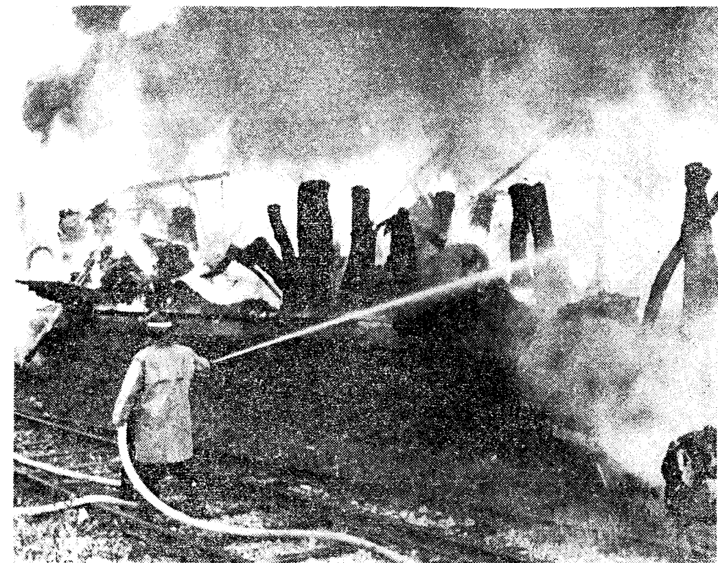
EIN GROSSBRAND ZERSTÖRTE am Montagfrüh eine etwa 50 m lange Lagerhalle der Firma Findeisen & Weber, Ettlingen. Aus noch unbekanntem Gründen ist hier Feuer ausgebrochen, das in den lagernden Roh- und Fertigwaren reiche Nahrung fand und sehr schnell um sich griff. Die Freiwillige Feuerwehr Ettlingen konnte verhindern, daß die Flammen auch auf den angebauten Fabrikationsaal mit seinen neuen Maschinen übergriff. Nach einigen Aufräumarbeiten kann hier die Arbeit wieder aufgenommen werden. Fotos (2): M. Karg
